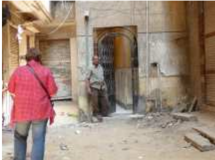
ingang nieuw schoolgebouw Cairo - Ain Shams
