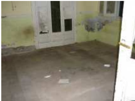
oud schoolgebouw, Cairo, wordt gesloopt
